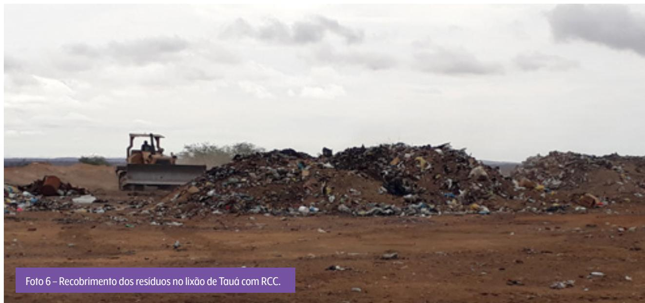
Foto 6 – Recobrimento dos resíduos no lixão de Tauá com RCC.
